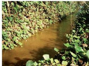
Las acequias: el agua es desviada del río o arroyo mediante una zanja o canal artificial denominada acequia, consiguiendo, en los molinos de cubo, la cota de altura suficiente para producir la energía capaz de impulsar el rodezno; en los molinos de canal, la acequia conseguía alejar el edificio de la corriente de agua, evitando de este modo los temidos peligros de las riadas
