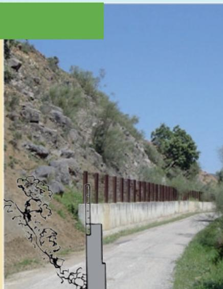
Esquema de la estructura del muro de contención empleado
